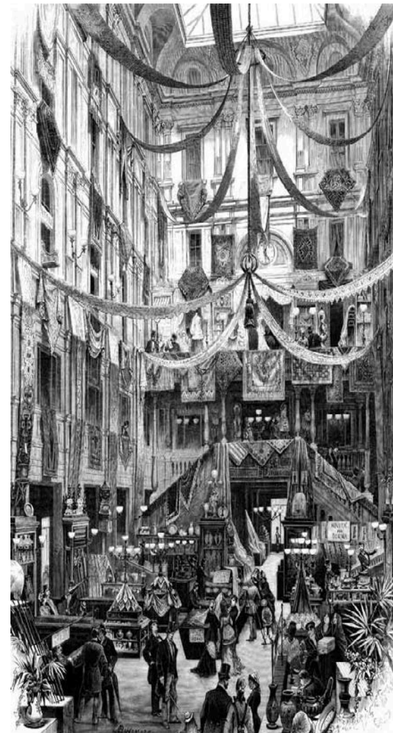
Magazzini "La Rinascente"
